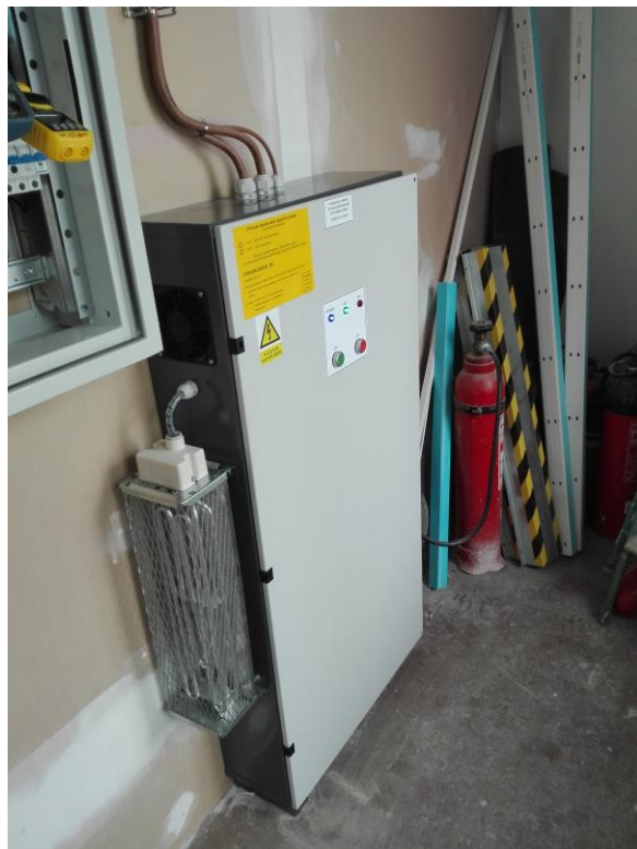
Zdroj: ASTIP LIFTBACK 15kVA / 60 min. pro výtah OTIS Akce: ubytovna Hodonín, výtah OTIS 6,7kW
