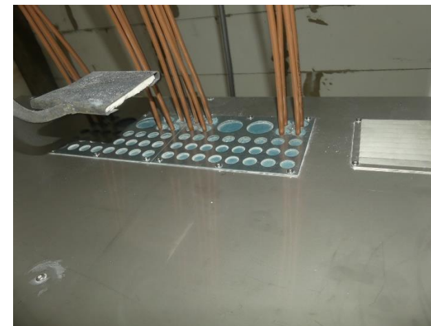
Požární prostupy předpřipravené výrobcem CELSION
