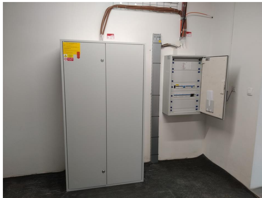
Zdroj: ASTIP 240kVA/30kVA 45 min. EI45 Akce: Sportovní hala Topolčany, napájení ventilátorů, klapek
