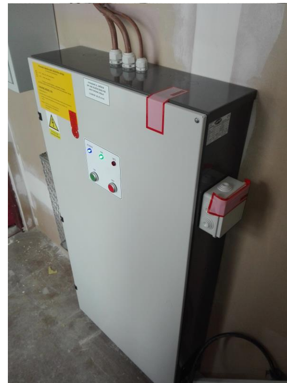
Zdroj: ASTIP LIFTBACK 15kVA / 60 min. pro výtah OTIS Akce: ubytovna Hodonín, výtah OTIS 6,7kW
