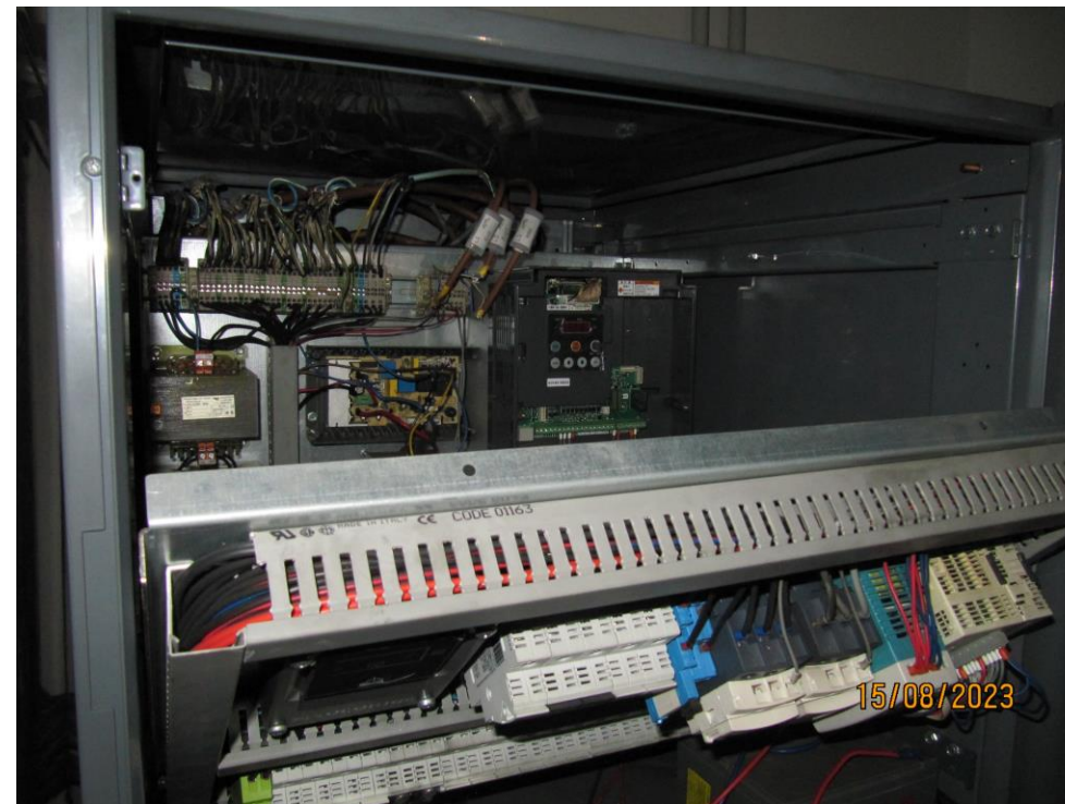
Zdroj: 403-055-120/403-075-120 UPS 5,5(7,5)kVA Akce: DPMB, úprava servisní haly autobusů CNG, Brno-Slatina
