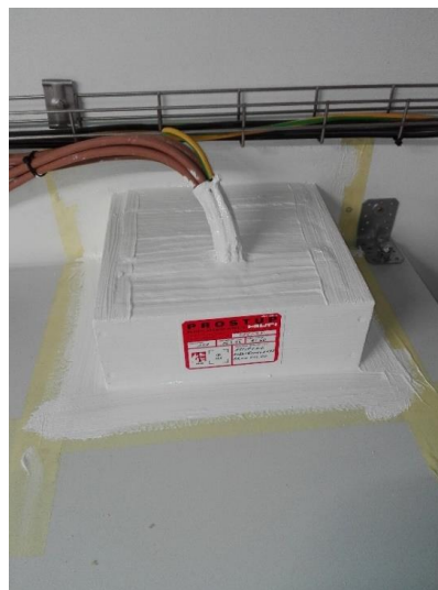
Pož. vstup připraveným otvorem
