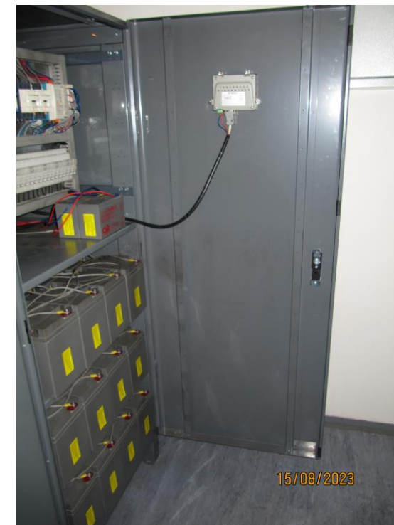
Zdroj: 403-055-120/403-075-120 UPS 5,5(7,5)kVA Akce: DPMB, úprava servisní haly autobusů CNG, Brno-Slatina
